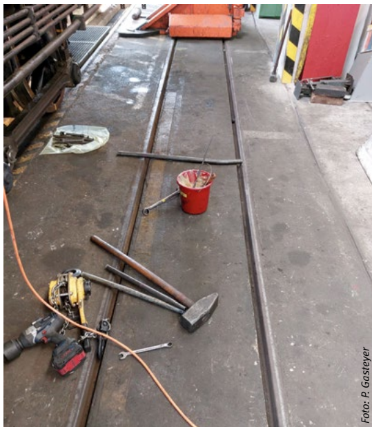
Abbildung 2: Stolpergefahr: abgelegte Werkzeuge im Bewegungsbereich des Verkehrsweges
