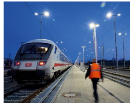
Stralsund – Abstell- und Behandlungsanlage
