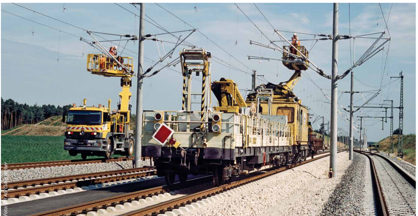
Elektrifizierungsarbeiten auf der Strecke Nürnberg–Ingolstadt
