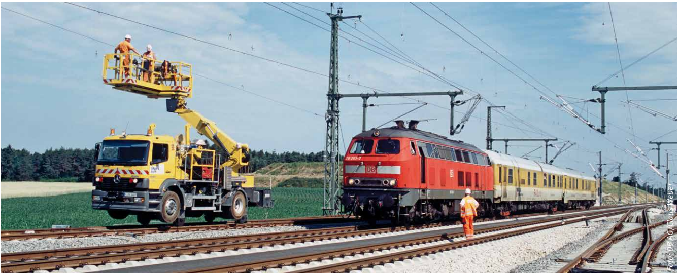
Fahrleitungsabnahme auf einer in Bau befindlichen Schnellfahrstrecke
