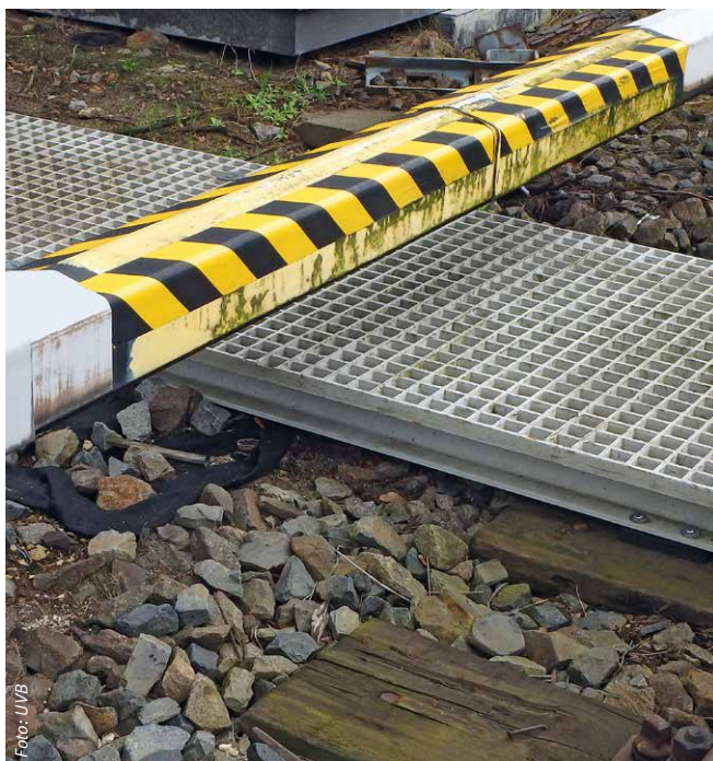
Geeignete Standfläche zum Übersteigen
