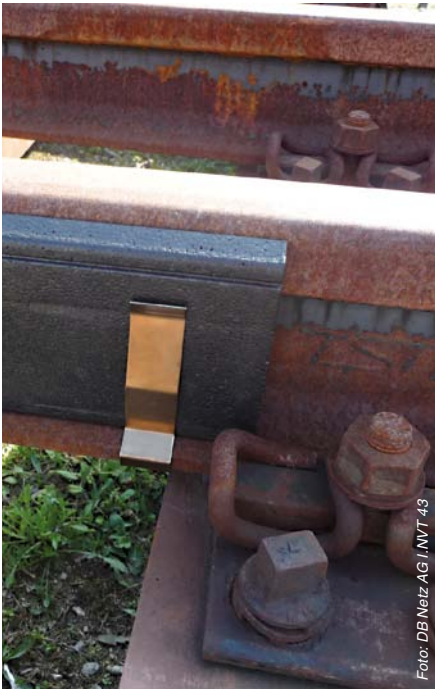
Abbildung 1: Anbringung der Isolierung am Schienensteg
