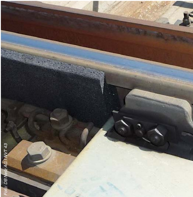
Abbildung 5: Abschluss der Schienenstegisolierung an einem Weichenantrieb
