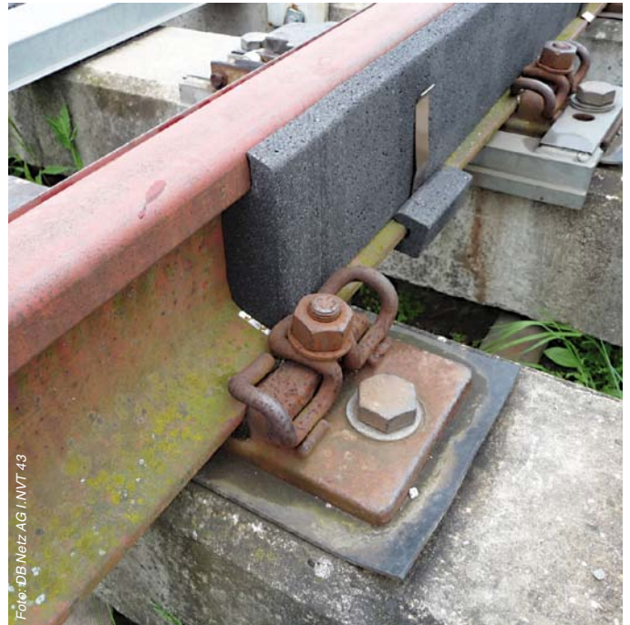
Abbildung 6: Formschlüssiger Abschluss der Schienenstegisolierung
