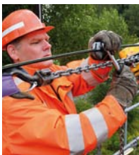
Unser Titelbild: Oberleitungsarbeiten
