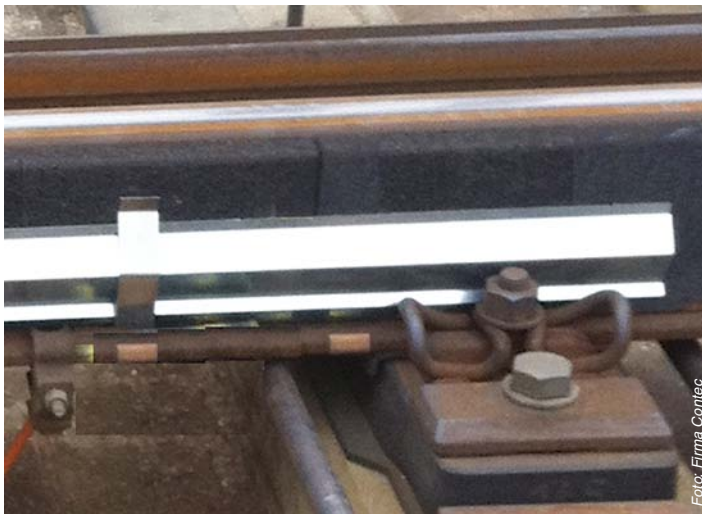
Abbildung 1: Anbringung der Isolierung am Schienensteg
