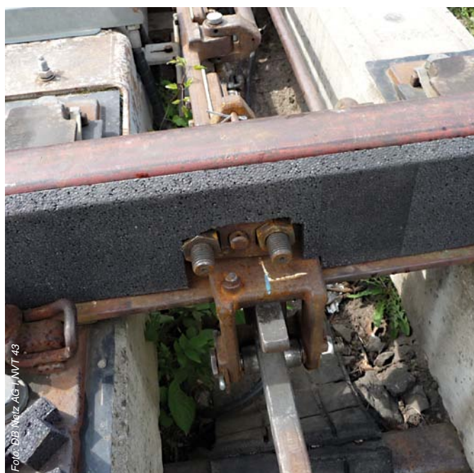
Abbildung 8: Passend ausgeschnittene Schienenisolierung am Verschlussfach
