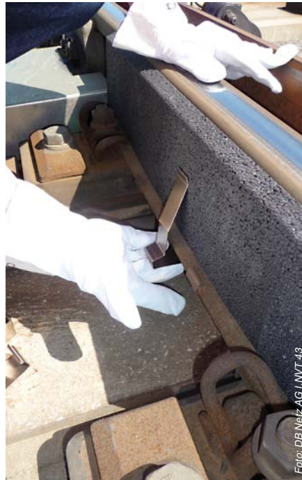
Abbildung 2: Anbringung der Befestigungsklammer
