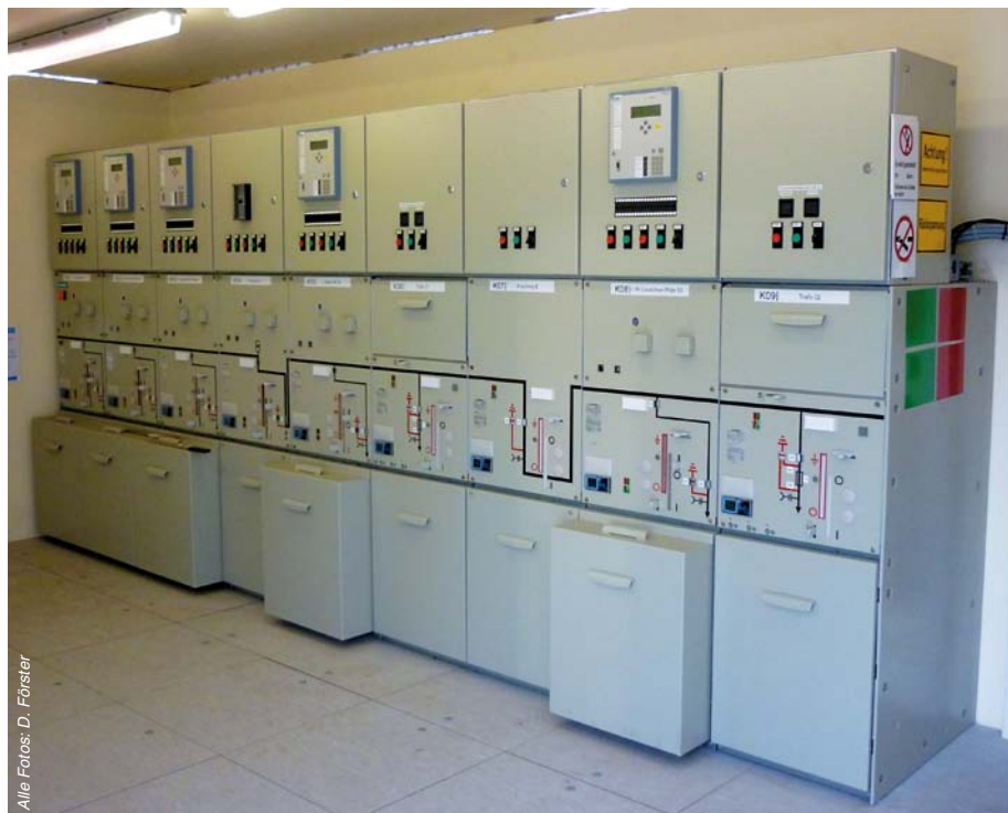
Abbildung 4, oben: SF6-isolierte Schaltanlage 8DH10 in der TST 51 an der Station MDR. Abbildung 5, unten: SF6-isolierte Schaltanlage MINEX in der TST in der Station Wilhelm-Leuschner-Platz
