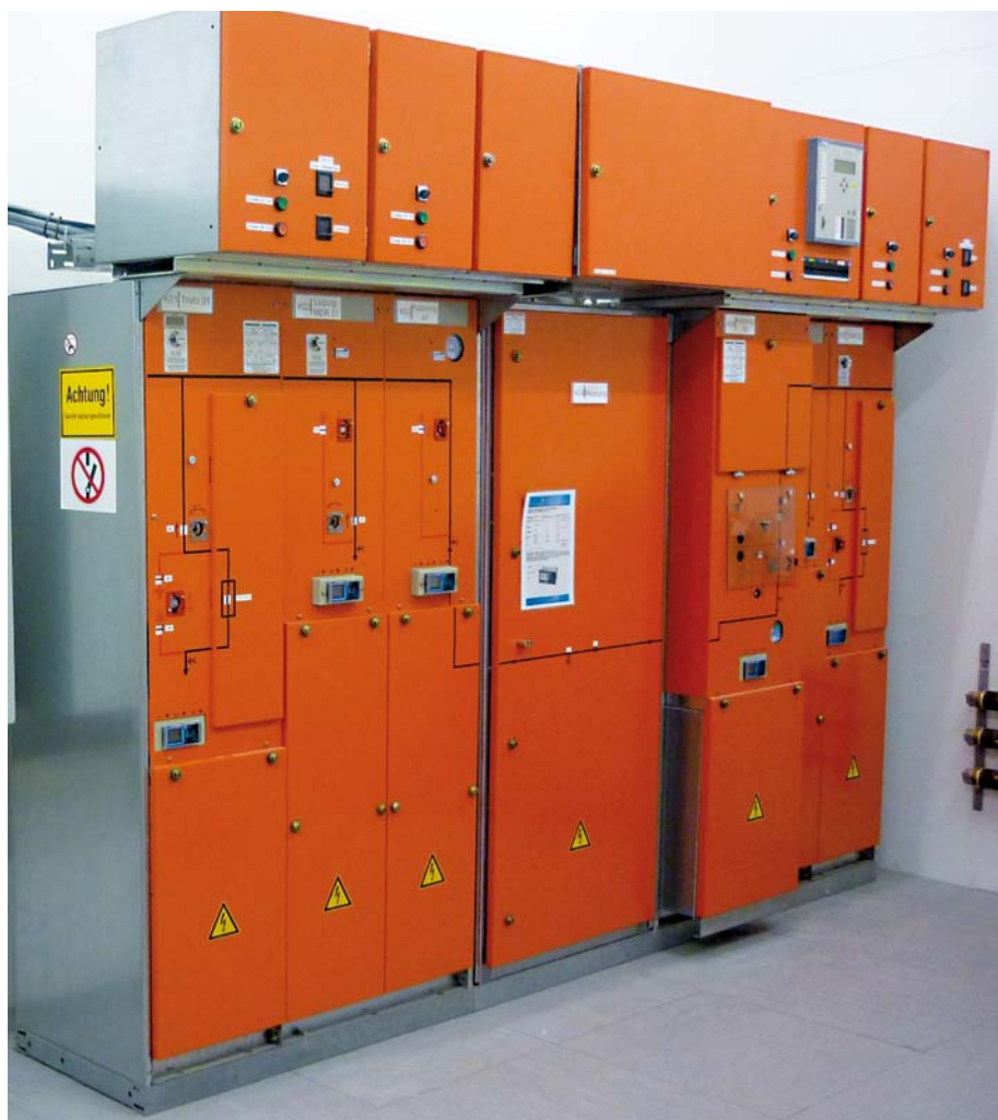
Abbildung 4, oben: SF6-isolierte Schaltanlage 8DH10 in der TST 51 an der Station MDR. Abbildung 5, unten: SF6-isolierte Schaltanlage MINEX in der TST in der Station Wilhelm-Leuschner-Platz
