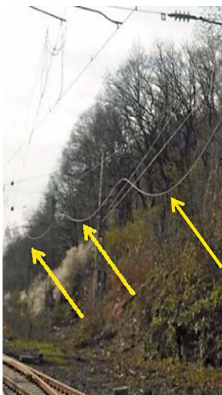
Abbildungen 1 und 2: Durch gestohlenes Rückankerseil hängt die Oberleitung durch. Es kann in Folge zu weiteren Schäden kommen.
