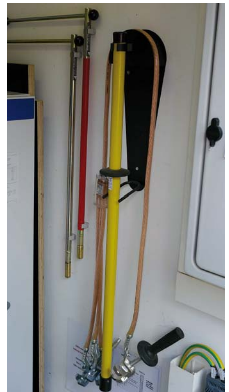
Abbildung 4 (unten links): Beispiel zur Anordnung der Aushänge und Zubehör in einer Kompakttrafostation. Abbildung 5 (unten rechts): Erdungs- und Kurzschließvorrichtung (EuK) mit Erdungsstange inkl. Haltevorrichtung.
