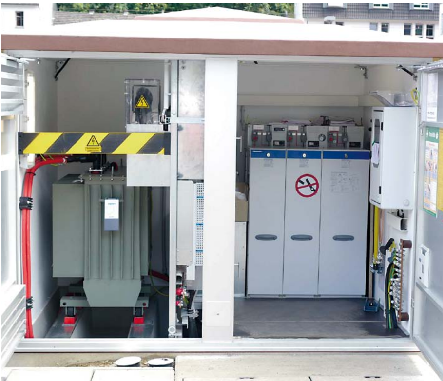
Abbildung 4 (unten links): Beispiel zur Anordnung der Aushänge und Zubehör in einer Kompakttrafostation. Abbildung 5 (unten rechts): Erdungs- und Kurzschließvorrichtung (EuK) mit Erdungsstange inkl. Haltevorrichtung.
