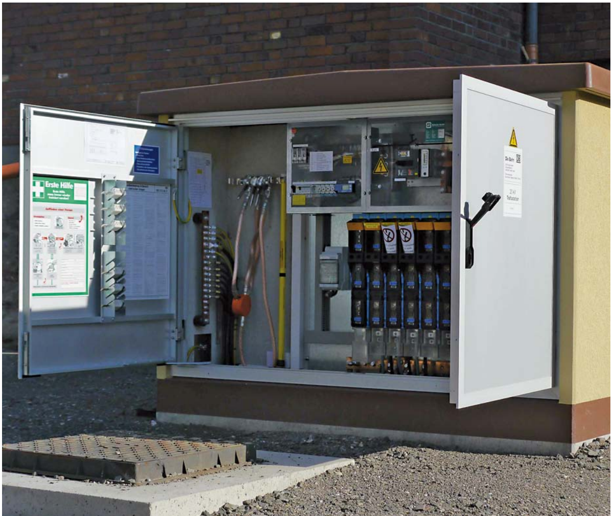
Abbildung 4 (unten links): Beispiel zur Anordnung der Aushänge und Zubehör in einer Kompakttrafostation. Abbildung 5 (unten rechts): Erdungs- und Kurzschließvorrichtung (EuK) mit Erdungsstange inkl. Haltevorrichtung.
