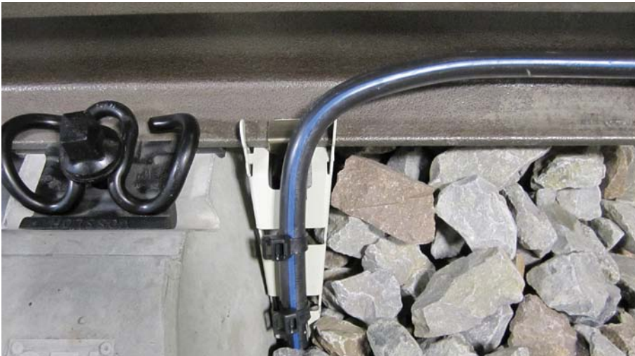
Abbildung 2: Schienenfußzuführung (SFZ) mit einem Aluminiumkabel (Foto: Fa. Photon Meissener Technologies GmbH)
