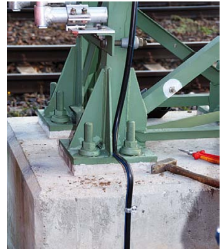
Abbildung 3: Verlegung am Mast (Foto: Fa. Cembre)
