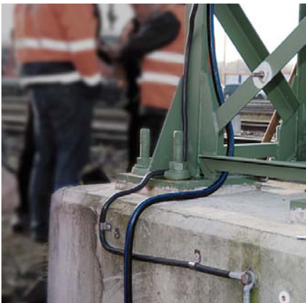
Abbildung 4: Verlegung am Mast (Foto: Fa. Cembre)
