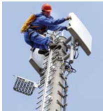
Unser Titelbild: Servicearbeiten auf einem GSM-R-Sendemast in Königs Wusterhausen. Foto: DB AG/ Hartmut Reiche.
