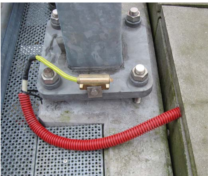
Abbildung 6: Anwendungen einer SDS: Offene Bahnerdung – indirekte Anbindung eines Mastes.
