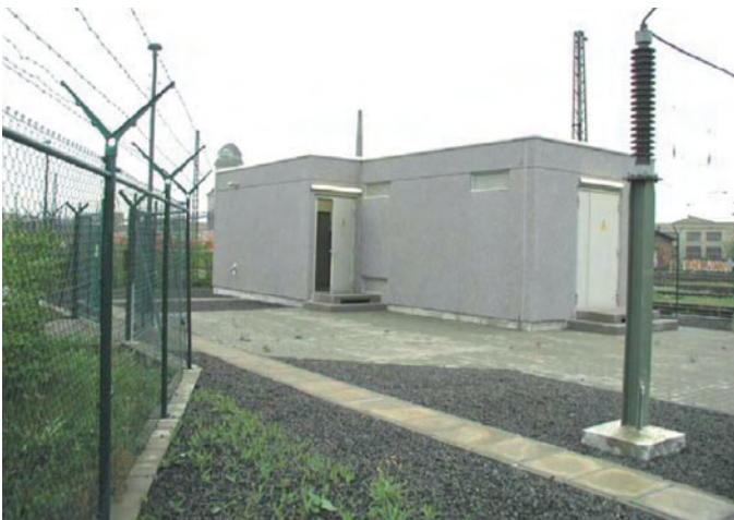
Abbildung 3: Außenansicht Innenraumschaltanlage.
