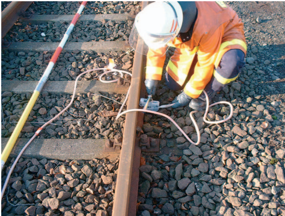
Abbildung 2: Ein Angehöriger der Feuerwehr führt eine Bahnerdung durch.
