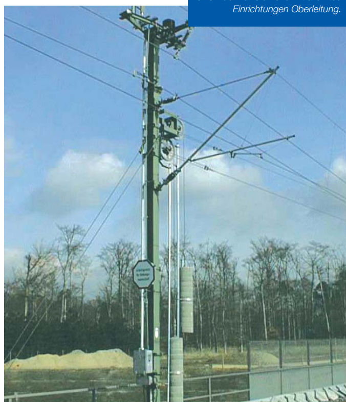
Abbildung 1: OLSP der Fa. Siemens mit allen technischen Einrichtungen Oberleitung.
