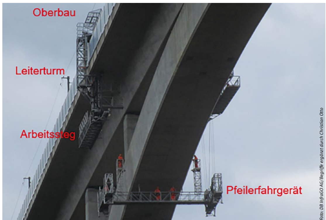
Abbildung 2: Aufbau der Brückenuntersicht- geräte (Begriffe)
