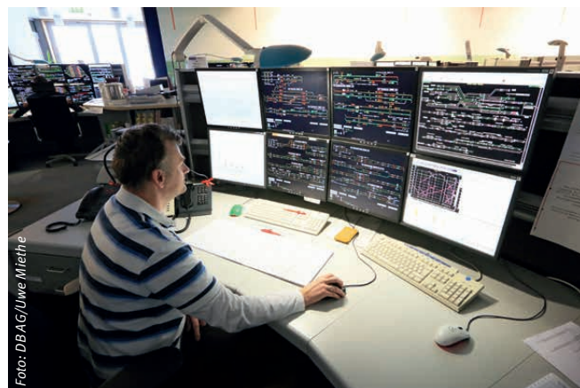
Der Fahrdienstleiter steuert und überwacht von der Betriebszentrale aus die Betriebsabwicklung auf den Bahnhöfen und Streckenabschnitten.
