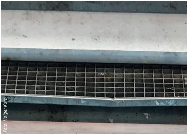
Verformter Gitterrost
