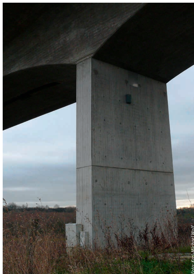
Abbildung 2: Elektro-Installation unter der Brücke nur mittels Hubsteiger erreichbar. Grund (Gelände) unter der Brücke ist nicht befahrbar; es existiert keine befestigte Aufstellfläche
