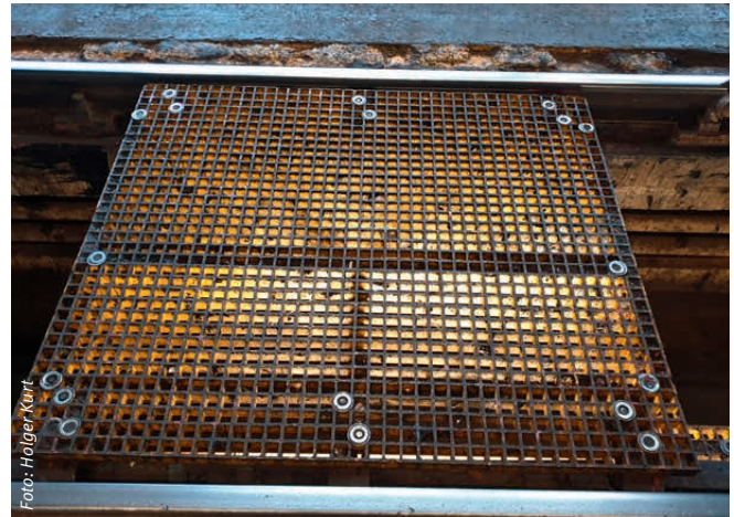
GFK-Gitterrost (glasfaserverstärkter Kunststoff)
