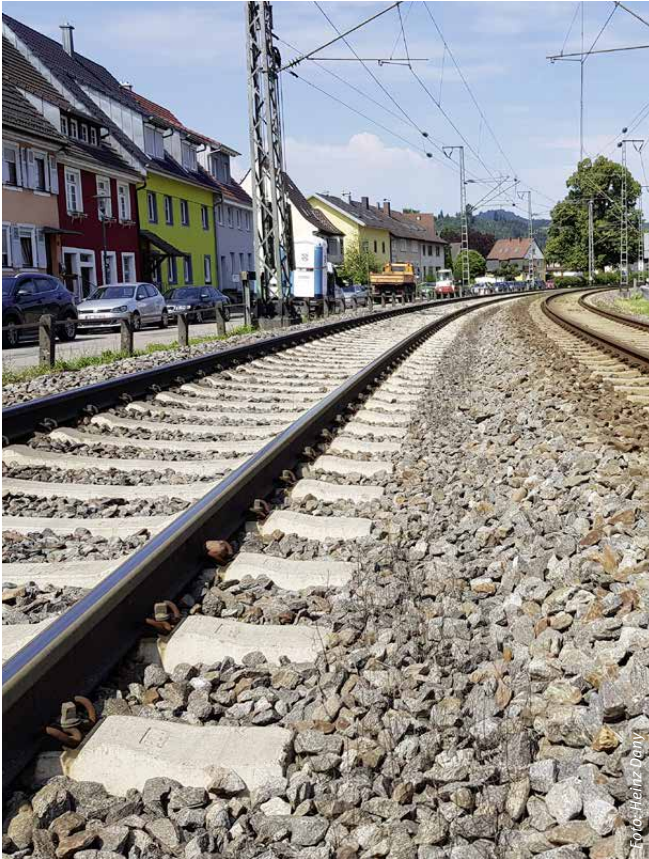
Abbildung 1: Gleisbogen mit Überhöhung
