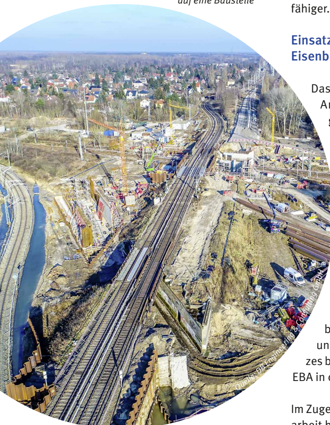
Blick vom Multikopter auf eine Baustelle
