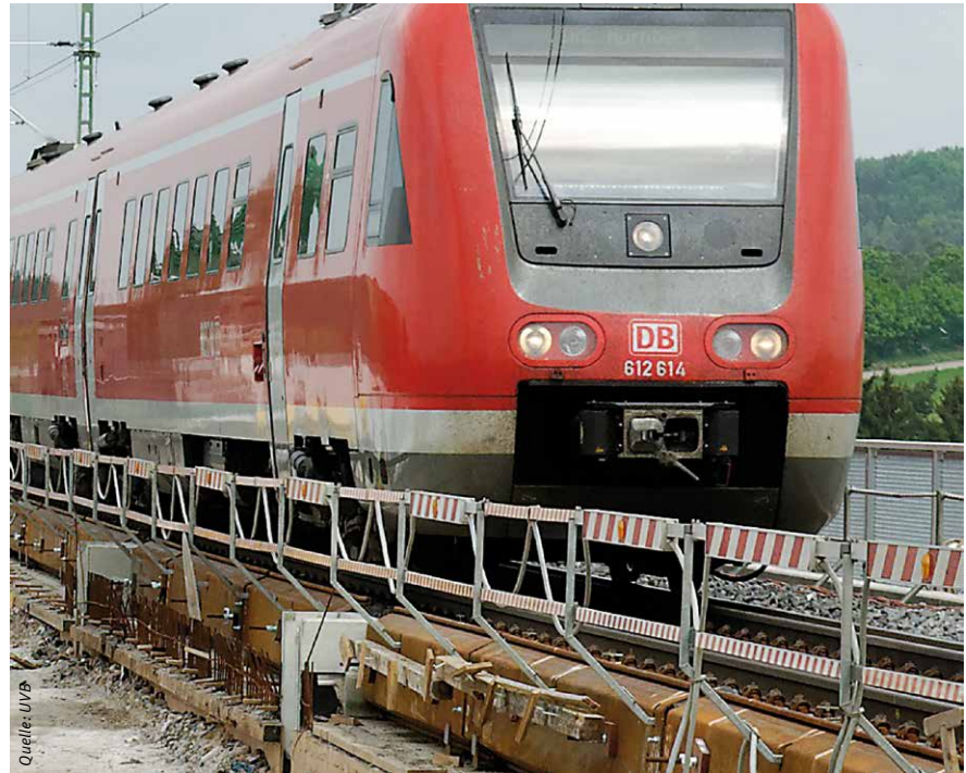
Abbildung 6: Feste Absperrung als Sicherungsmaßnahme bei Gleisbauarbeiten; Sicherheitsmarkierung mit rot-weißen Streifen
