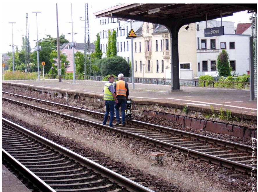
Abbildung 1: Absperrposten im Uv-gesperrten Gleis
