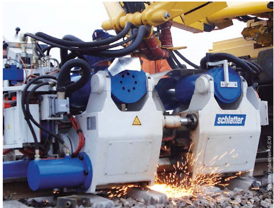
Abbildung 1: Automatisches Abrennstumpfschweißen – Schweißmaschine System AMS100
