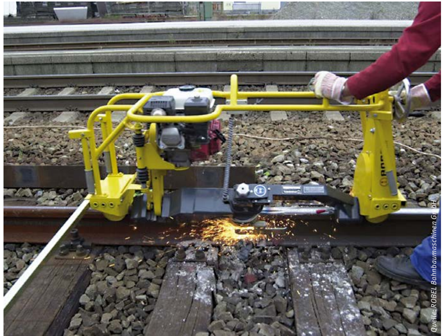
Abbildung 3: Handgeführte Schienenschleifmaschine zum Schleifen nach Schweißarbeiten
