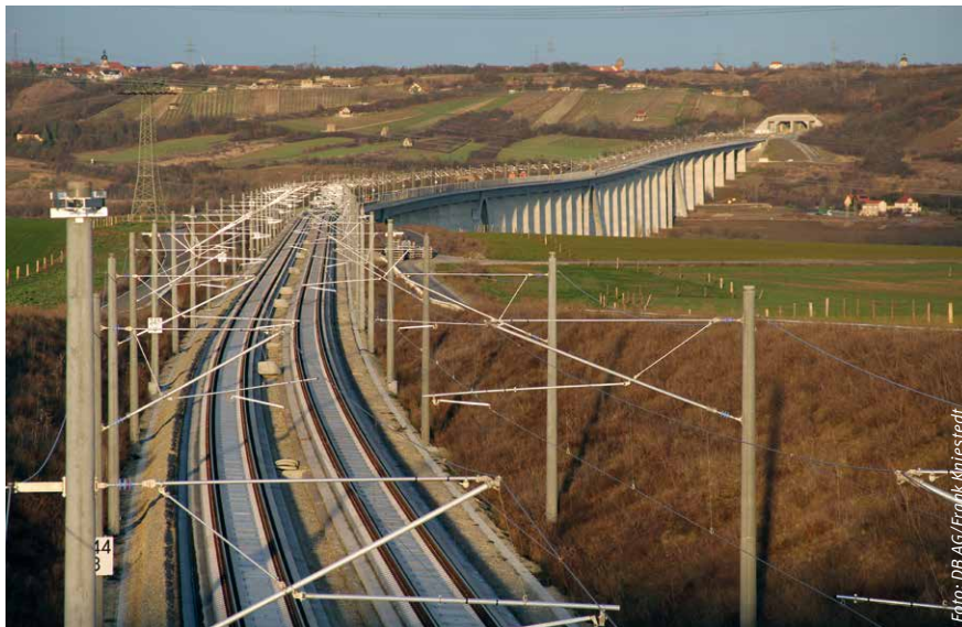
Trasse der Schnellfahrstrecke VDE 8.2. bei Karsdorf
