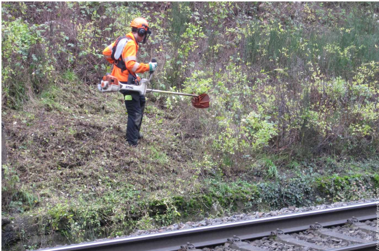
Vegetationsarbeiten mit Freischneider neben dem Gleis
