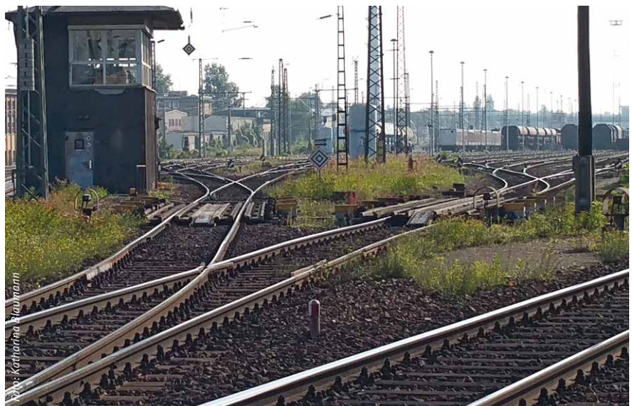
Blick auf eine halbautomatische Ablaufanlage eines Rangierbahnhofes. Die Wagen werden hinter dem Ablaufberg durch eine Gleisbremse gebremst.
