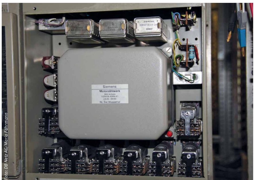
Achszähler Motorzählwerk
