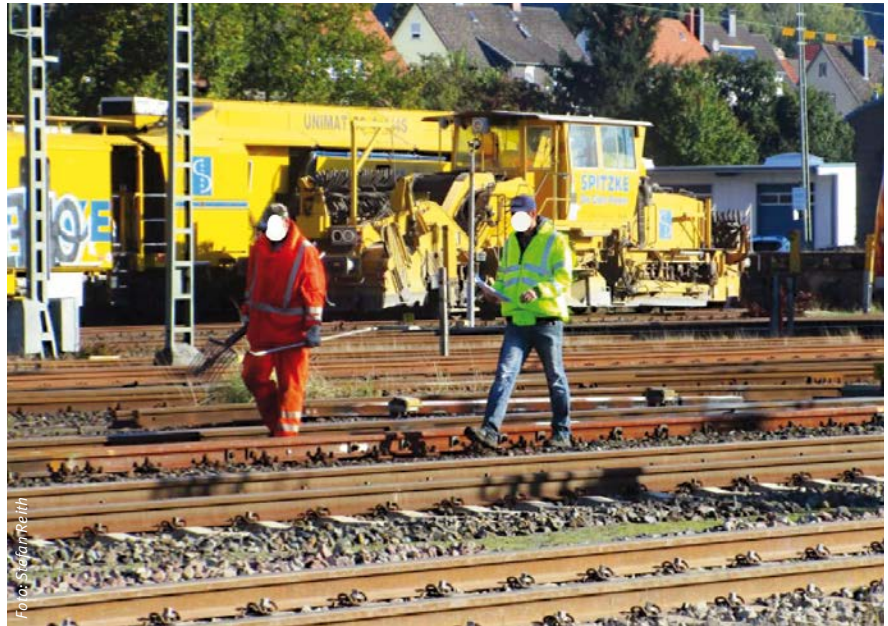
Abbildung 1: Regelkonformer Einsatz von Absperrposten
