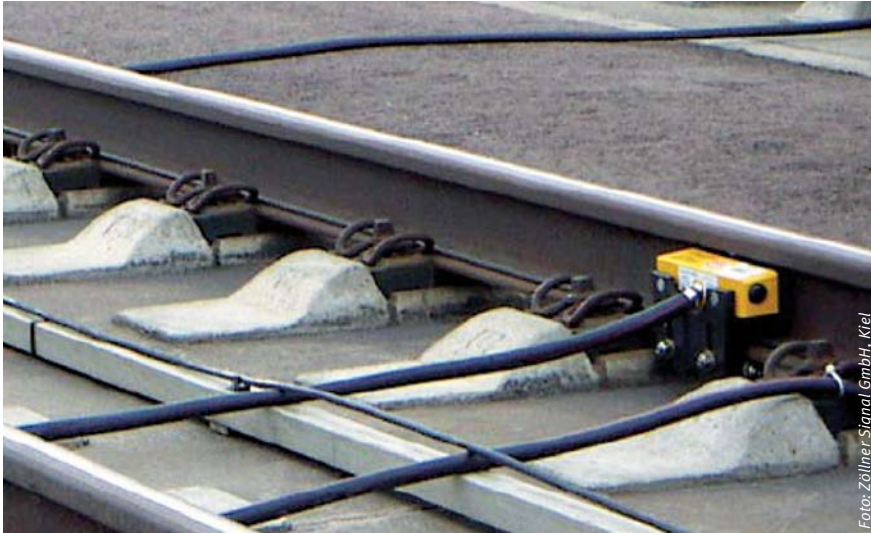
Abbildung 1: Technische Detektion einer Fahrt durch Schienenkontakt F 500
