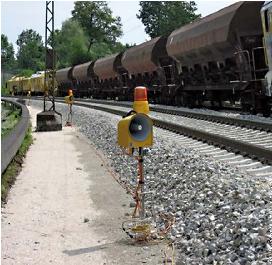
Kabelgestütztes ATWS der Fa. Schweizer Electronic AG, Reiden
