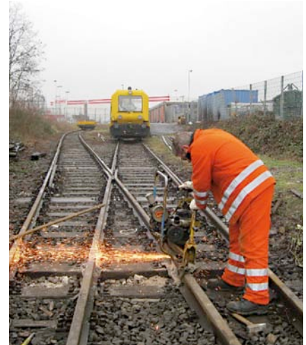
Abbildung 4: Grobschliff
