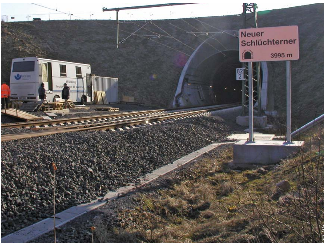
Die Messungen wurden im Neuen Schlüchterner Tunnel durchgeführt.
