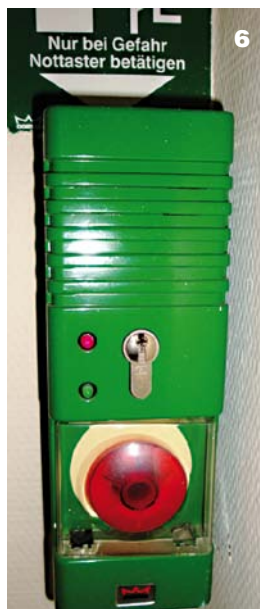
Abbildung 5: Schlüsselschalter für Vorrangschaltung im Aufzug
