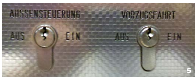
Abbildung 5: Schlüsselschalter für Vorrangschaltung im Aufzug
