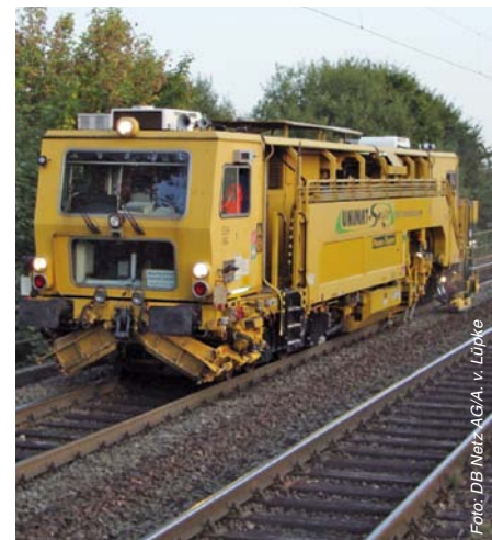
Einzelfehlerbeseitigung per Gleisstopfmaschine
