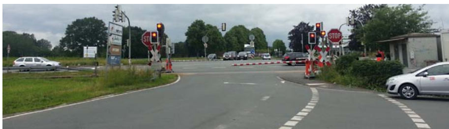
BÜ mit schwierigen Straßenverhältnissen und TH-BÜP in geschlossener Stellung
