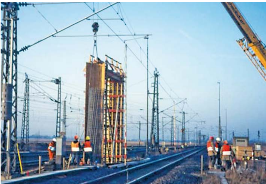
Abbildung 7: Kranarbeiten bei frei geschalteter Fahrleitung: vor und hinter der Arbeitsstelle ist eine Bahnerdungsvorrichtung eingebaut.
