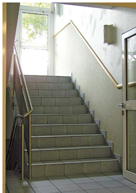
Abbildung 6: Zweiläufige Treppe mit Zwischenpodest
