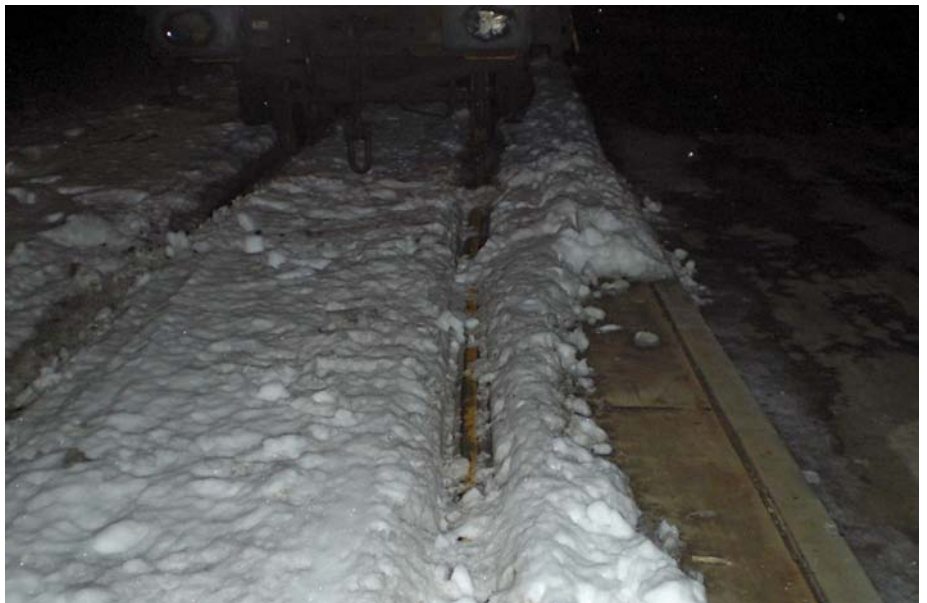
Abbildung 2: Vereiste Spurrillen in einem Gleisanschluss (Montag 3. Januar 2012)
