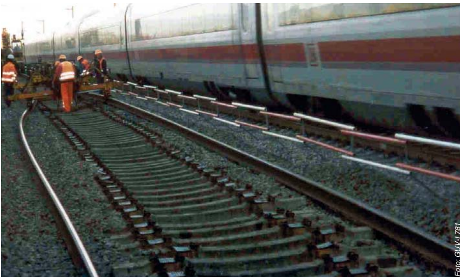
Abbildung 2: Am Schienenfuß montierte feste Absperrung zwischen Arbeitsbereich und Betriebsgleis bei 4,7 m Gleisabstand.
