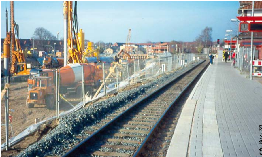
Abbildung 1: Bauzaun als Feste Absperrung zwischen Arbeitsbereich und Gleisanlage.
