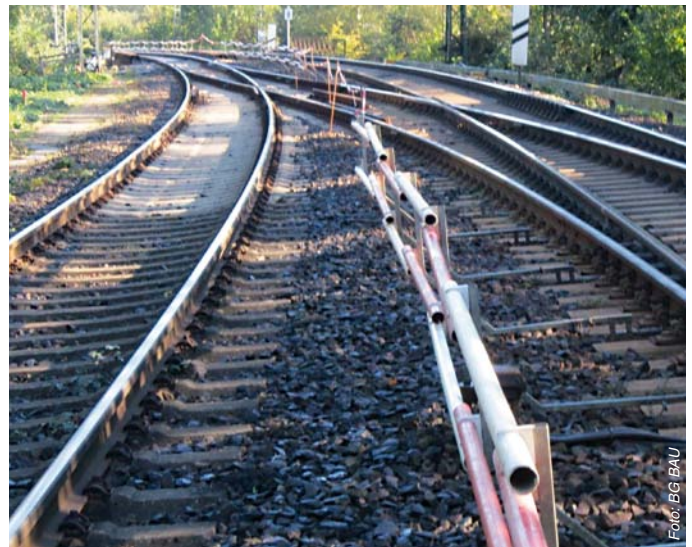
Abbildung 3: Geeignete Feste Absperrungen können auch im Bereich von Weichenzungen montiert werden (links). Unterbrechungen der FA in Weichenbereichen werden mit sichtbarer Abgrenzung kenntlich gemacht und während der Arbeiten z.B. mit Absperrposten gesichert (rechts).
