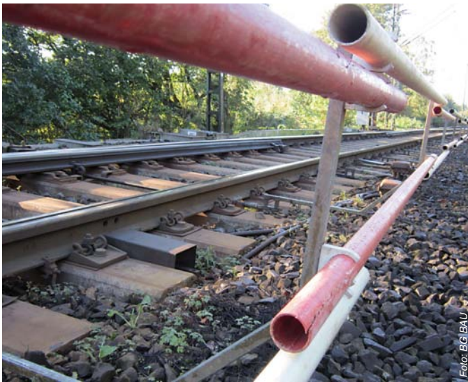
Abbildung 3: Geeignete Feste Absperrungen können auch im Bereich von Weichenzungen montiert werden (links). Unterbrechungen der FA in Weichenbereichen werden mit sichtbarer Abgrenzung kenntlich gemacht und während der Arbeiten z.B. mit Absperrposten gesichert (rechts).
