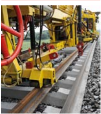
Unser Titelbild: Gleisumbauzug im Einsatz.
