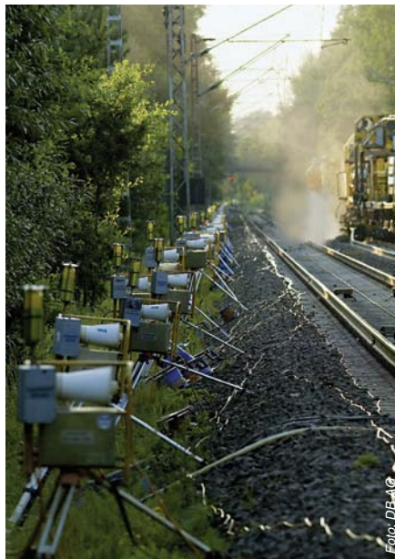
Abbildung 3: Automatisches Warnsystem zur Warnung von lauten Gleisbaumaschinen mit kurzem Abstand der Warnsignalgeber – ohne Maschinenwarnung
