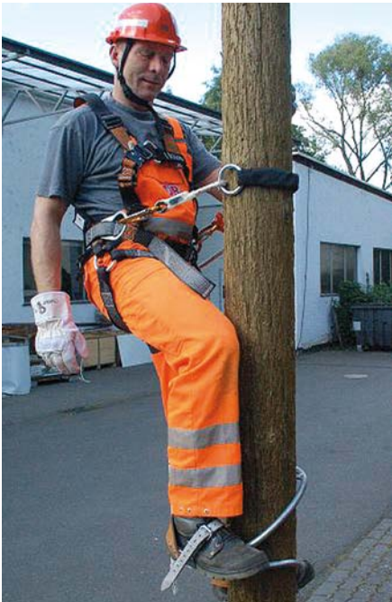
Abbildung 1: PSA gegen Absturz, Auffanggurt nach DIN EN 361 mit integrierter Haltefunktion
