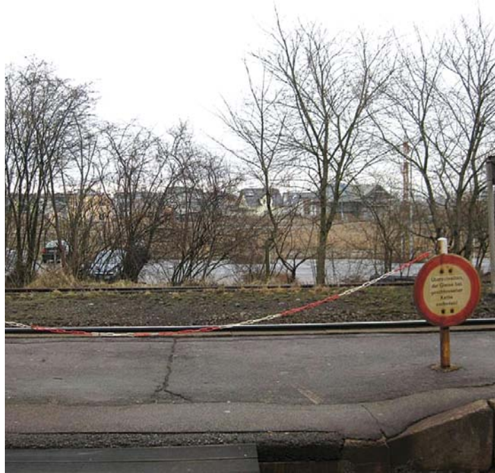
Abbildung 4: RÜ mit Absperrung hinter dem Gleis
