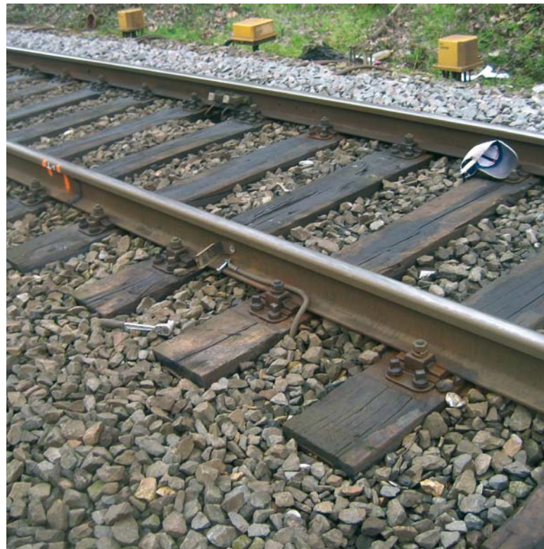
Abbildung 2: gelöster Rückleiter der EWHA (Foto: DB Netz AG/G. Wenzel)
