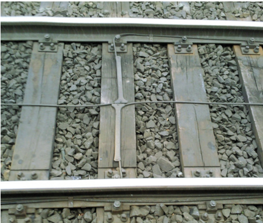
Abbildung 1: Kreuzungsstelle eines Linienleiters (Foto: Norbert Speiser)
