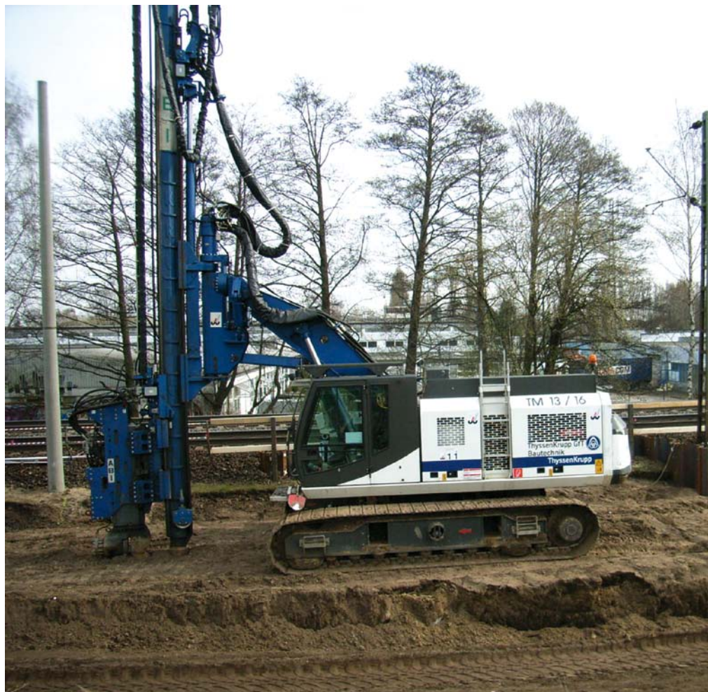
Abbildung 12: Um die Gefährdung des Bahnbetriebs durch den Einsatz der Ramme auszuschließen wurden die Rammarbeiten nur unter Sperrung des Gleises neben der Arbeitsstelle ausgeführt.
