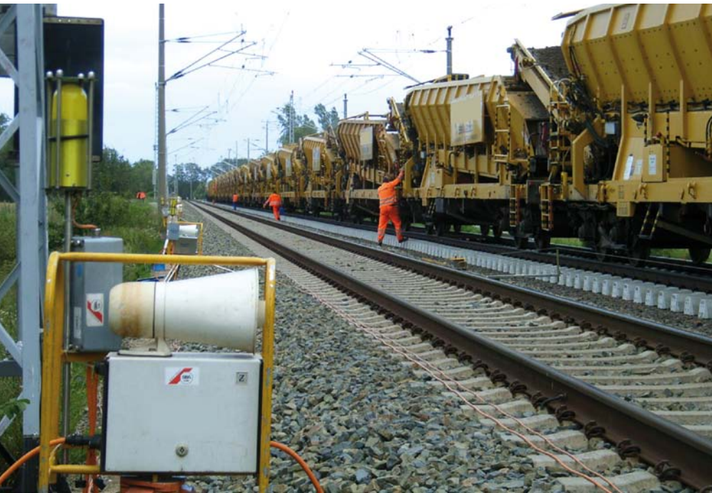
Abbildung 2: Arbeitsplätze auf der Nachbargleisseite der Materialwagen sind bei Fließbandverfahren auch am Baulosanfang und -ende vorhanden. Die „Entfaltungslänge“ ist dann größer als die Bauloslänge.
