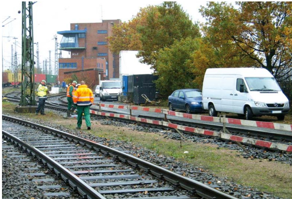
Abbildung 6: Feste Absperrung als „Zwangsführung“ zur Querungsstelle, die durch einen Posten gesichert wird (Gleis im Vordergrund gesperrt).
