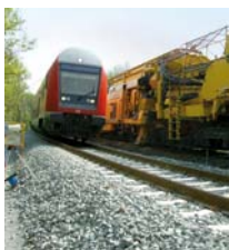
Unser Titelbild: Maschineller Einbau einer Planumsschutz- schicht.
