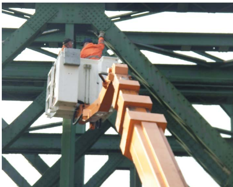
Abbildung 2: Hubarbeitsbühne bei der Kontrolle von Bauwerken
