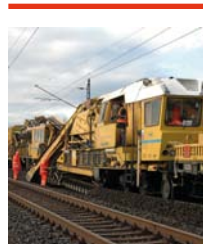
Unser Titelbild: Bettungsreinigungsmaschine im Einsatz.
