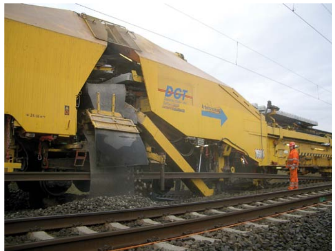
Abbildung 2: Auf der Betriebsgleisseite mitgehender Bediener an einem Umbauzug.
