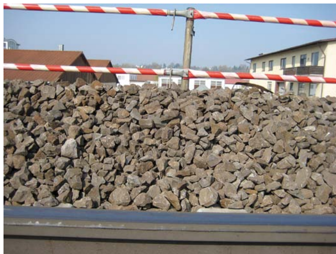
Abbildung 7: Der Schotterberg im Mittelkern macht die feste Absperrung unwirksam.
