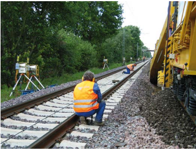
Abbildung 3: Kontrolltätigkeiten im Gefahrenbereich des Nachbargleises.
