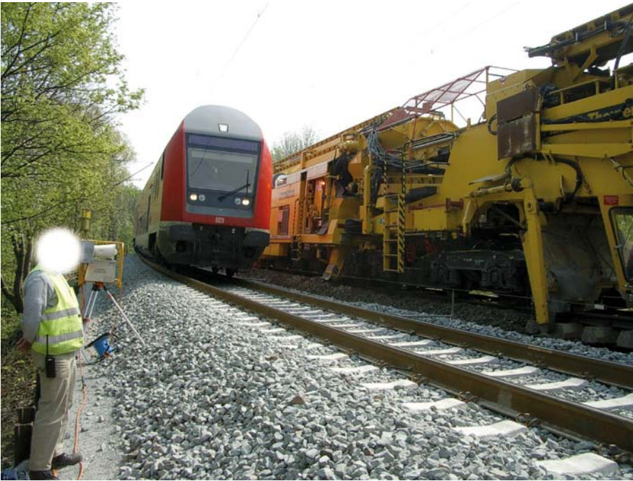
Abbildung 13: Überwachungsposten auf dem Randweg des Nachbargleises im Bereich der Kernmaschine.
