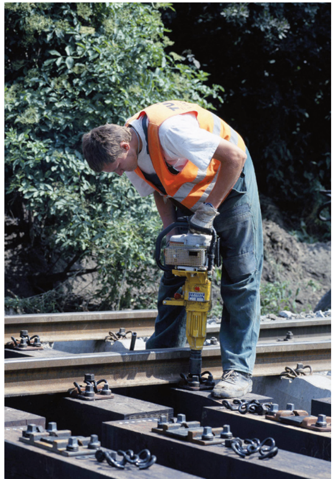
Abbildung 3: Beim Einsatz von Maschinen/Geräten im Gleisbau muss der Störschallpegel L_N für die Planung der Sicherheitsmaßnahme angegeben werden.
