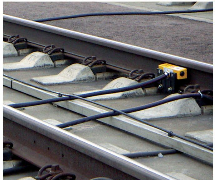
Abbildung 1: Zugdetektor F500 (montiert an einer Schnellfahrstrecke).
