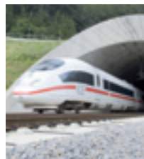
Unser Titelbild: Südliche Ausfahrt aus dem Schellenberg-Tunnel auf der NBS Nürnberg – München. Foto: DB AG/Günter Jayzbec.
