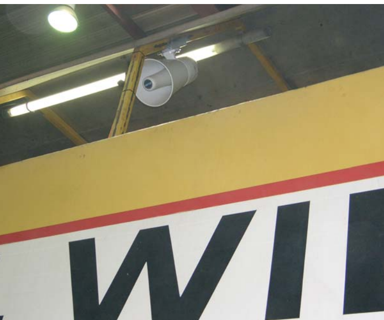
Abbildung 3: Einer der 12 Anbauplätze der Schallwandler: Verschraubung auf einer angeschweißten Trägerplatte.
