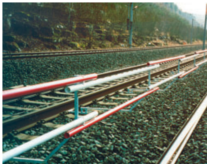
Beispiel einer Festen Absperrung, Werkfoto der Fa. EEP Vertrieb GmbH, Essen.
