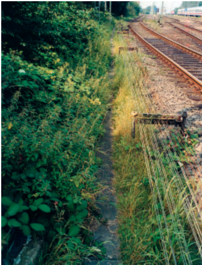
Abbildung 2: Gleisrandstreifen und Zugang zu einem Stellwerk.
