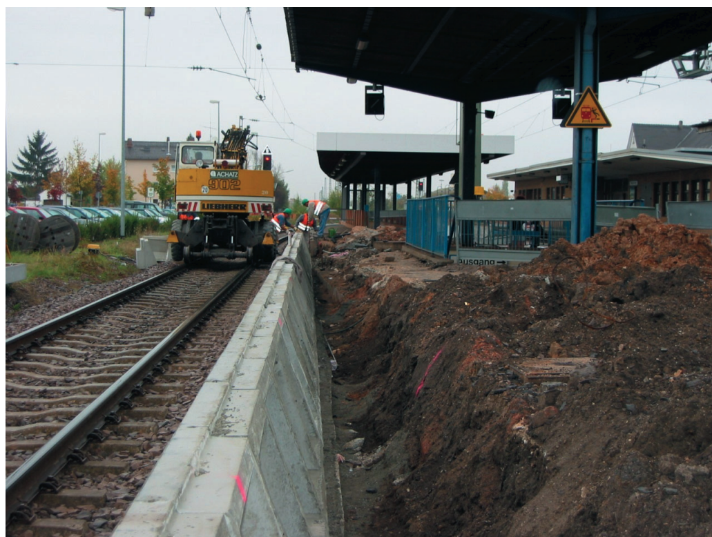
Arbeiten im Bereich von Gräben.
