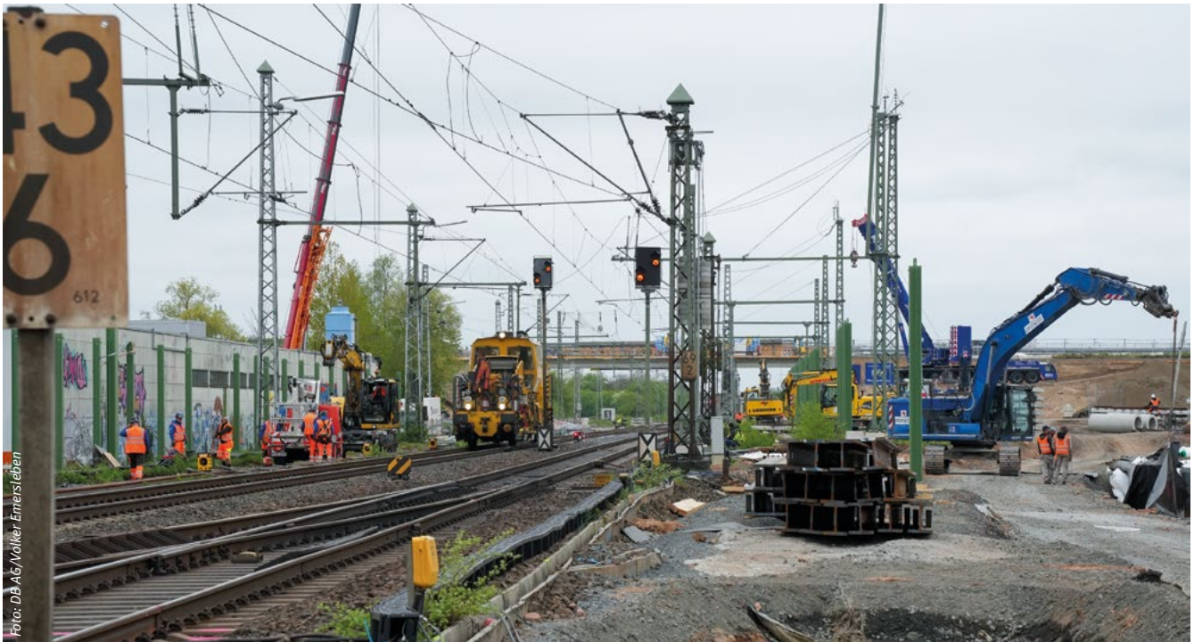
Abbildung 7: Kranarbeiten im Bereich von Oberleitungen sind grundsätzlich im spannungsfreien Zustand durchzuführen
