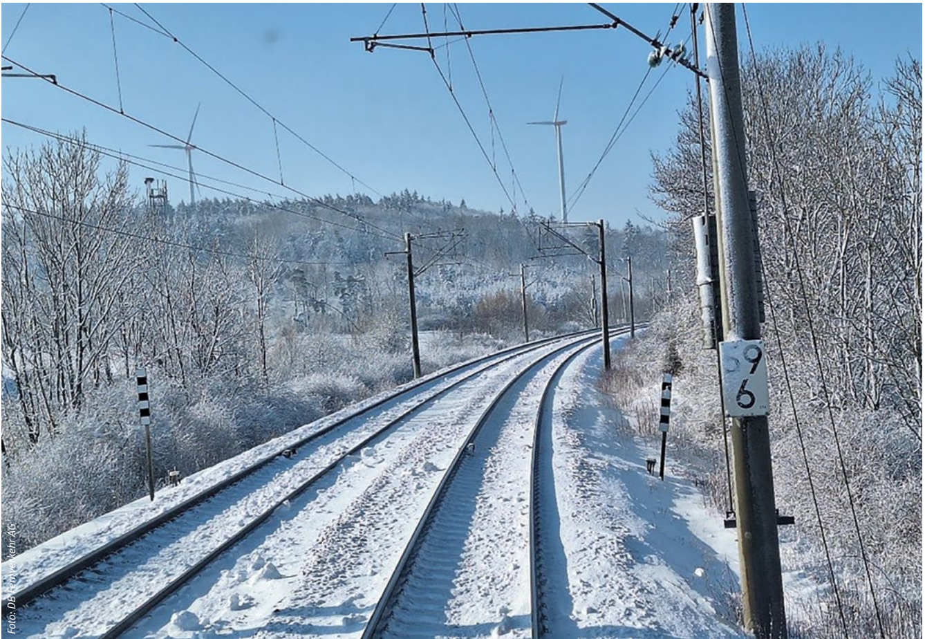
Abbildung 4: Kennzeichnung des Einschaltpunktes von Blinklichtern oder Lichtzeichen mit Fernüberwachung mittels Signal Bü 3 – Merktafel (DS 301), hier am Regel- und Gegengleis dargestellt
