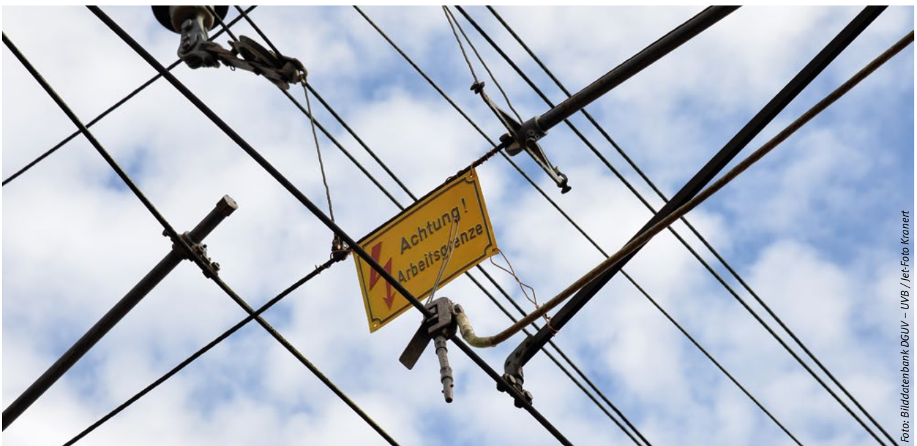
Abbildung 8: Für den Kraneinsatz sind Arbeitsgrenzen festzulegen
