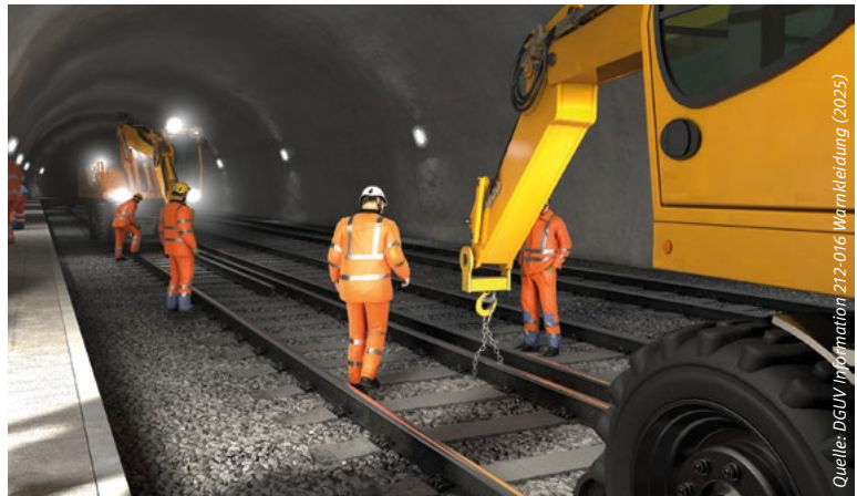
Abbildung 4: Für Beschäftigte, die Bau- und Instandhaltungsarbeiten im Gleisbereich ausführen, sollte wegen der besseren Erkennbarkeit Warnkleidung der Klasse 3 gewählt werden
