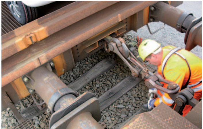
Abbildung 9: Beim Entkuppeln ist der Lrf erheblichen Lärmbelastungen durch ausströmende Druckluft ausgesetzt.
