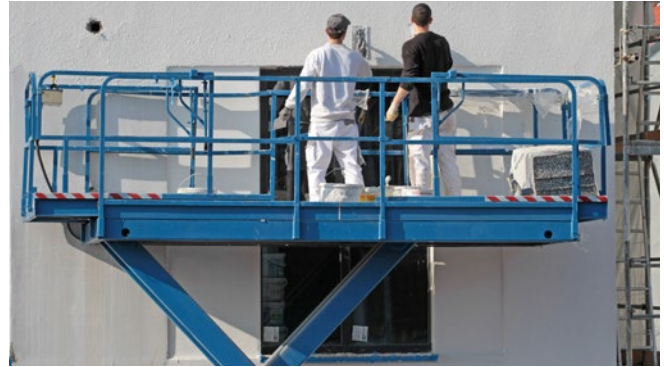
Abb. 28 Fassadenarbeiten mit Materialtransport
