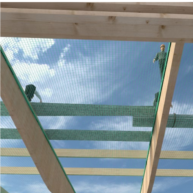
Abb. 9 Lauf- und Arbeitsstege auf nicht durchsturzsicheren Bauteilen unter Verwendung von Schutznetzen als Absturzsicherung
