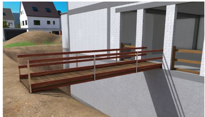
Abb. 7 Laufsteg mit Trittleisten (wegen Rutschgefahr) und Seitenschutz
