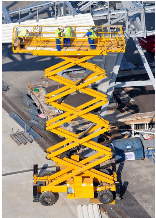
Abb. 16 Einsatz von Scheren-Hubarbeitsbühnen
