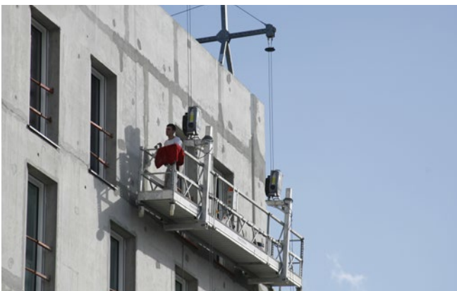
Abb. 14 Hochziehbares Personenaufnahmemittel bei Arbeiten an einer Fassade
