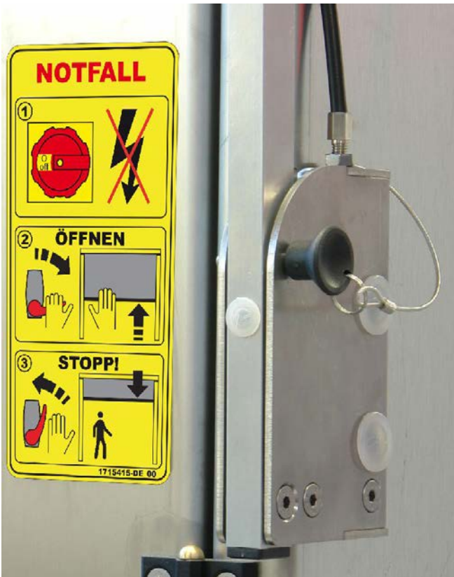
Abb. 5 Notbetätigung an einem Waschhallentor
